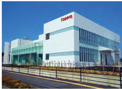
有機光エレクトロニクス実用化開発センター施設外観
